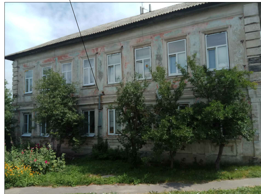
Увлажнение стен здания, отслоение штукатурки отслоение краски, волосяные трещины в штукатурном слое
