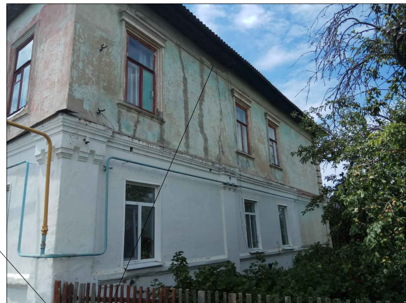
Увлажнение стен здания, отслоение штукатурки отслоение краски, волосяные трещины в штукатурном слое
