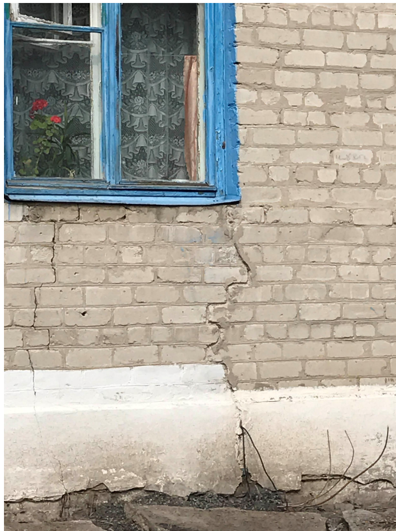
Фото 1-7. Увлажнение стен здания, отслоение штукатурки цоколя, трещины в наружных стенах с шириной раскрытия более 2 мм и глубиной до 2/3 толщины стены на площади до 10%. Замачивание стен здания.
