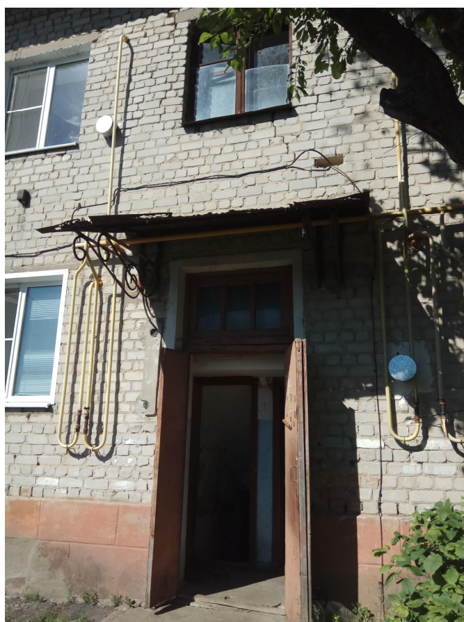
Фото 1-10. Увлажнение стен здания, отслоение штукатурки цоколя, трещины в наружных стенах с шириной раскрытия более 2 мм и глубиной до 2/3 толщины стены на площади до 10%. Замачивание стен здания.
