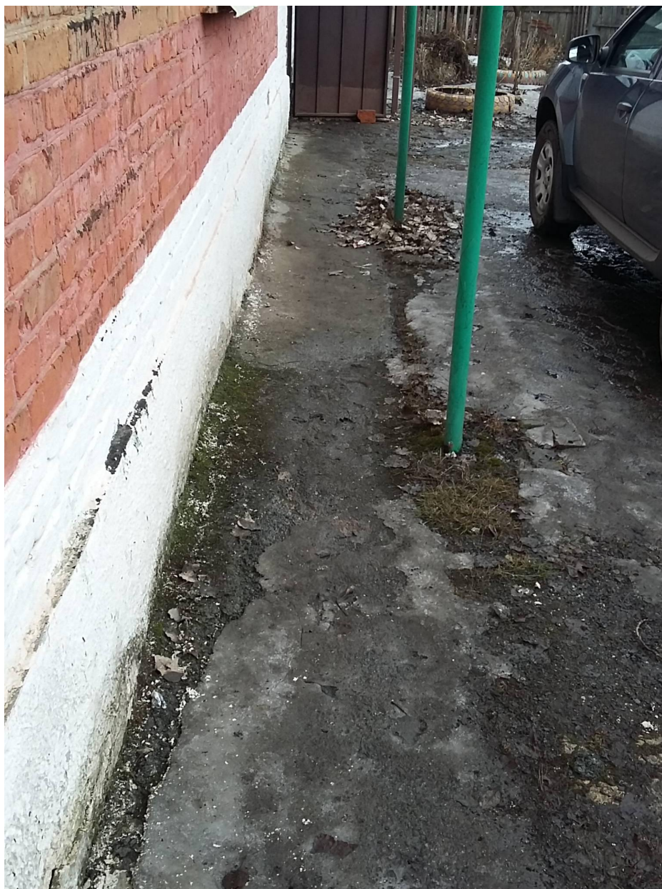
Фото 11 Существующее состояние отмостки здания
